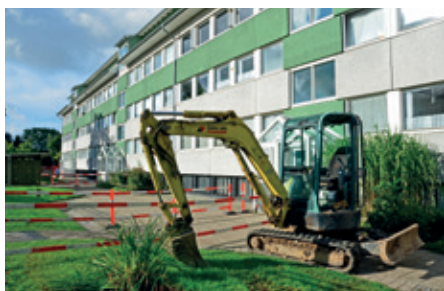
Den første blok afspærres.
