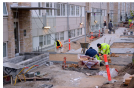
Håndværkere i gang med belægningen.
