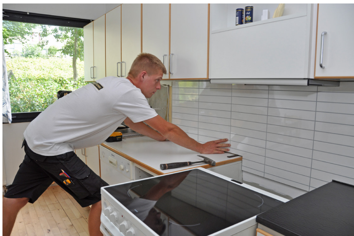
Vådumspanel sættes op på bagvæggen i køkkenet
