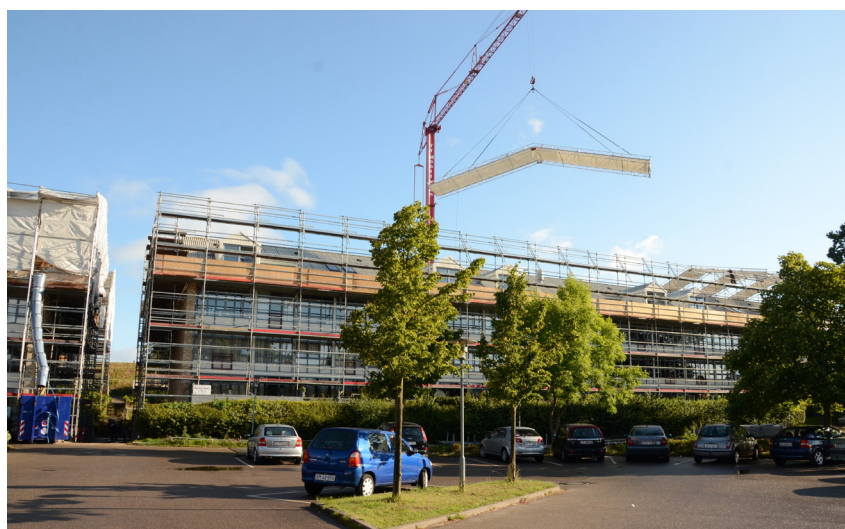
Teltet blev flyttet med en kæmpe kran fra et tag til et andet
