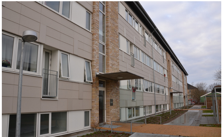
Nye kældervinduer, baldakin og glasvindfang. Nye lamper ved blokkene og cykelskure til dem, som havde valgt det på workshoppen.
