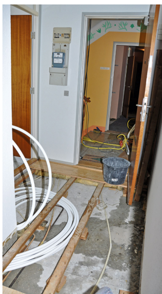
Det halve af gulvet i entréen blev brækket op...
