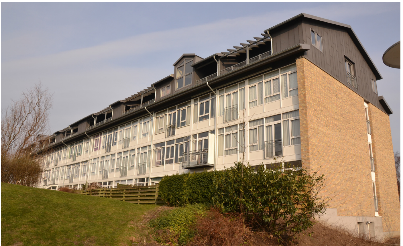
På blokkenes bagside blev pladerne malet eller skiftet til hvide, så de gamle farver ikke skæmmede helheden
