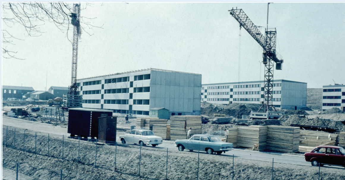
Sjældne fotos fra byggeriet af Vapnagård. Byggeriet startede i sommeren 1968 og 2 år efter stod de første 18 boligblokke omkring Hestens Bakke færdige. Siden fulgte de næste 39 blokke.
