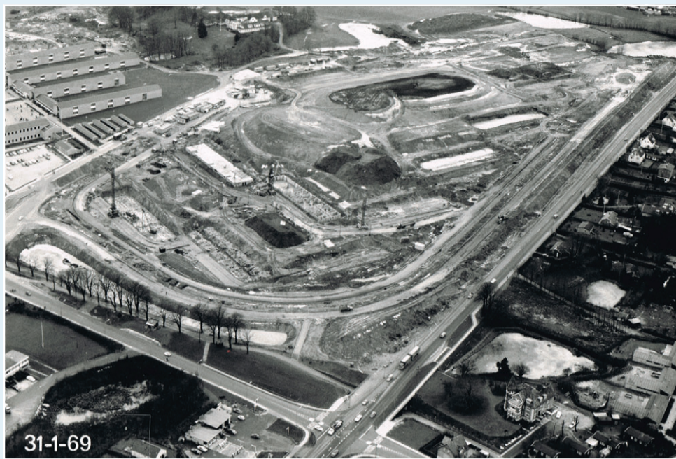
Den gamle gård, Vapnagaard, fik voldsomt selskab, da man i sommeren 1968 tog fat på opførelsen af de mange boligblokke på de tidligere marker. Her er byggeriet, der fik navnet Vapnagård, - med bolle-å - fotograferet i januar 1969. Øverst i billedet ses den gamle gård, der endnu ligger omgivet af sin træbevoksede have og en del af de nu udyrkede marker. Helsingør Kommunes Museer.
