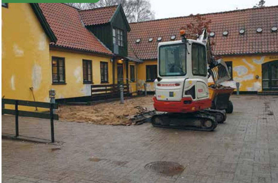
Her er arbejdet netop gået i gang, og du kan se, hvordan den gamle belægning så ud.
