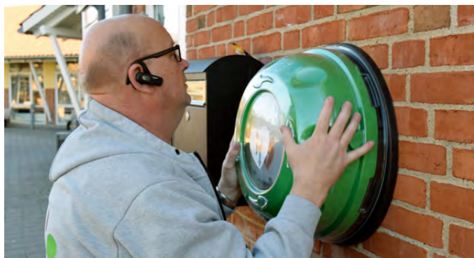
Elektriker Per Christensen monterer på ny hjertestarteren ved Vapnagaard Servicecenter. (Foto: Mikkel Frank)
